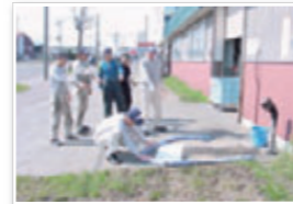
環境汚染防止のために 漏洩テストを実施
