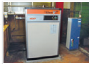
スクリーコンプレッサーと ドレンマスター(水と油を分離)を新設
